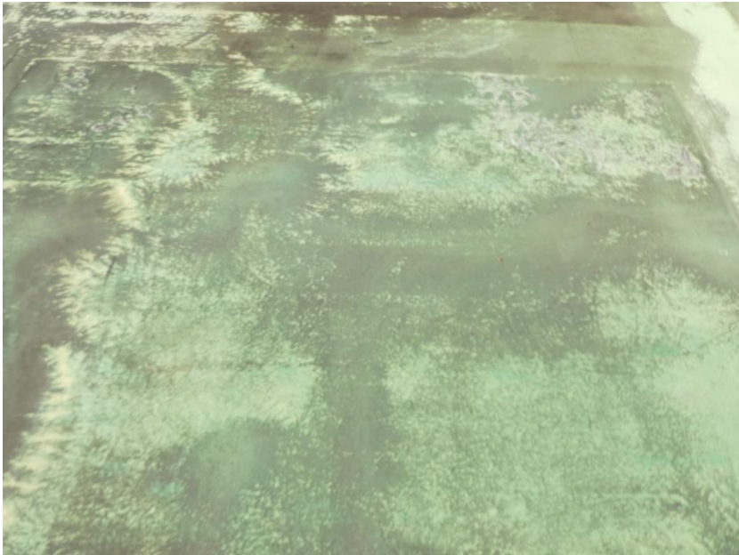
正常な状態の屋根
