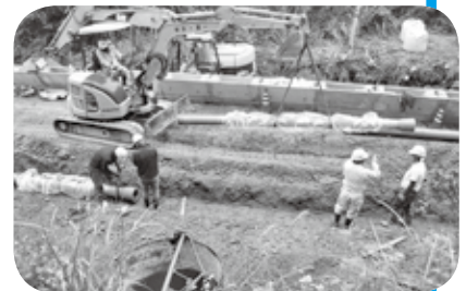
水道災害復旧工事
