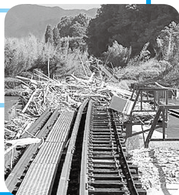
被災したくま川鉄道
