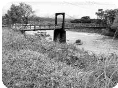
検討中の石田橋
