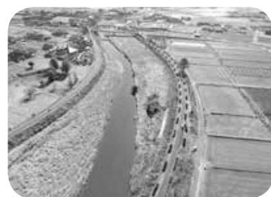
免田川 浚渫前
