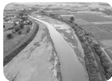
免田川 浚渫後
