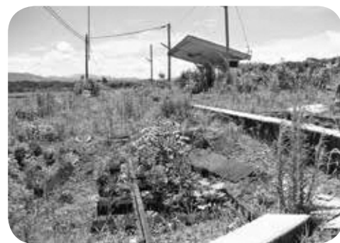
復旧が待たれるくま川鉄道 (7月豪雨で被害にあった川村駅)
