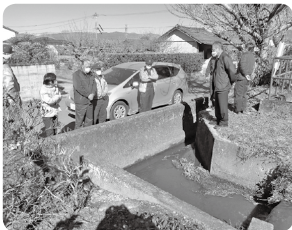
令和2年7月豪雨災害現地調査（永里地区）
