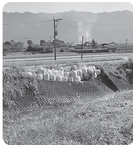
災害箇所の大型土のう
