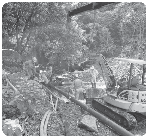
上川南水源地復旧状況
