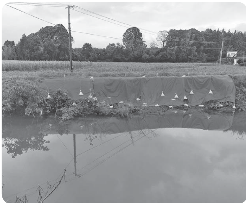
災害箇所のブルーシート張り
