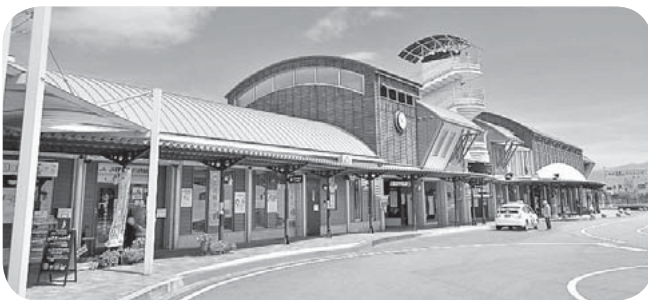
あさぎり町商工コミュニティセンター「ポッポ一館」
