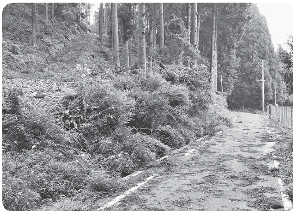
水源地貯水槽近くにある木材伐採、搬出に作られた作業道
