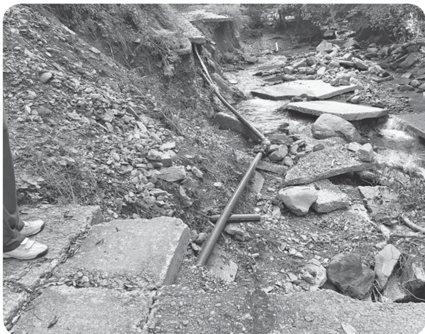
林道が消失 上水道管が出現
