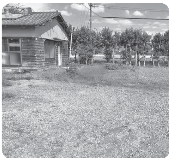
一部が解体され更地になった竹野団地
