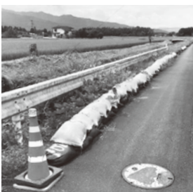
応急措置の二段土嚢を施されている河道
