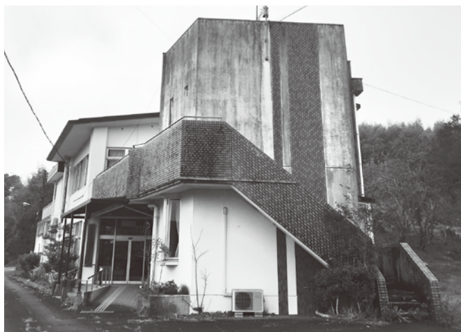
今後、検討を急ぐ施設等(写真は旧深田村保健センター)
