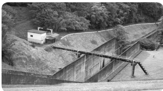
県営清願寺ダムの調圧水槽
