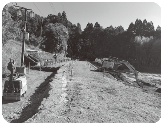
谷水薬師線道路拡張工事
