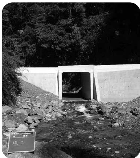
林道芋の八重線竣工
