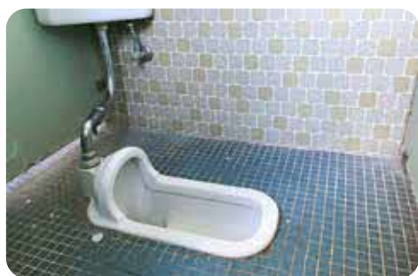
免田小体育館トイレ
