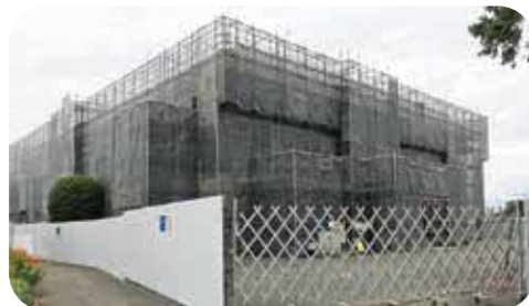
あさぎり中学校屋内運動場棟長寿命化改修
