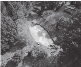
▲送水管の破損により枯れた池
