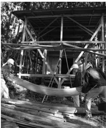
解体が始まった山上八幡神社（1/10）
