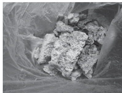
☆下水道管の詰まり（油の固まり）
