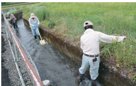
スコップで溝底をはがして進みます
