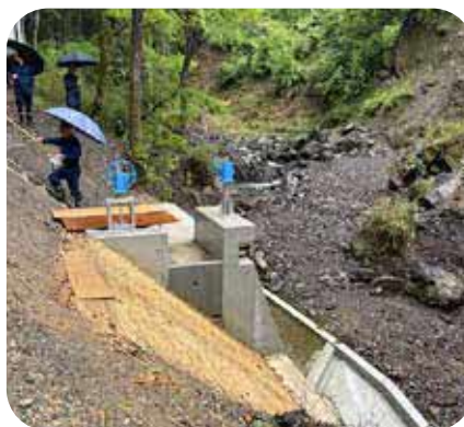
皆越農業用水復旧現場
