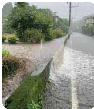
オーバーフローする排水溝
