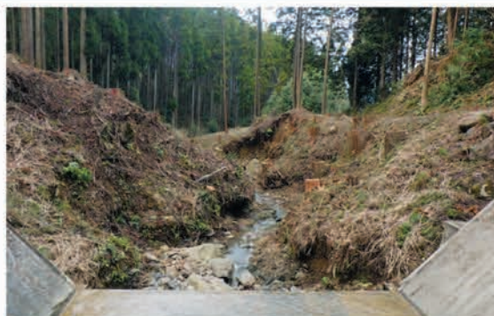
⑦柳谷 護岸工着工前
