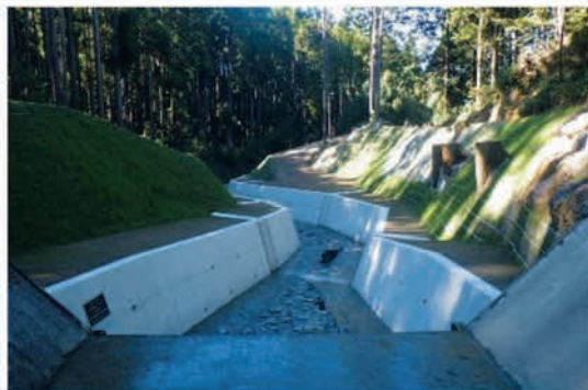
⑦柳谷 護岸工完成後
