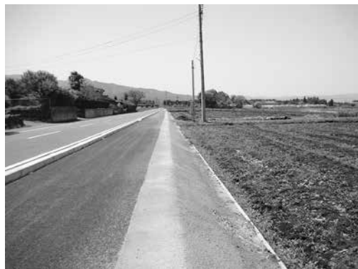
透土工法現場(齊堂原58号線)
