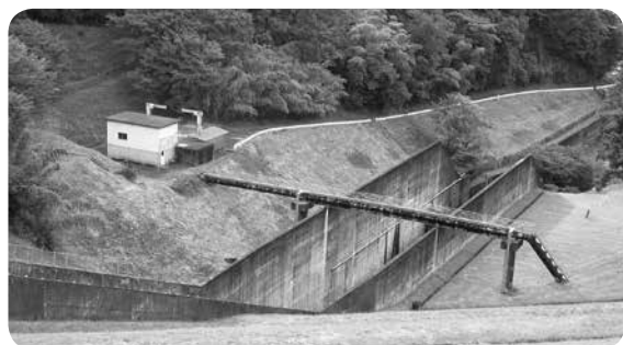
県営清願寺ダムの調圧水槽
