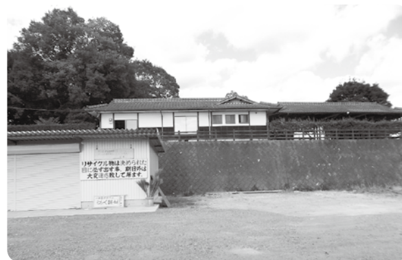
黒田公民分館建設予定地
