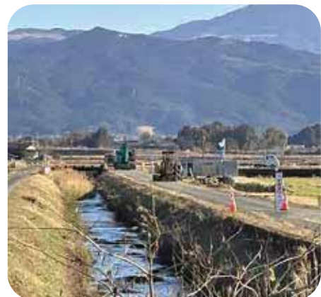
伊賀川河川改修工事
