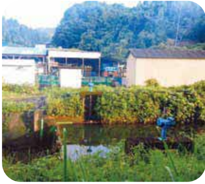
田頭川取水堰
